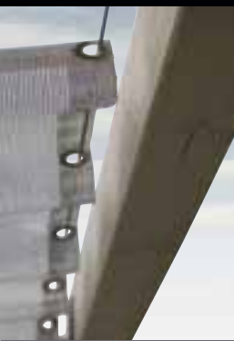
Wandspanner und Edelstahlrahtseil zur Befestigung eines Sonnensegels
